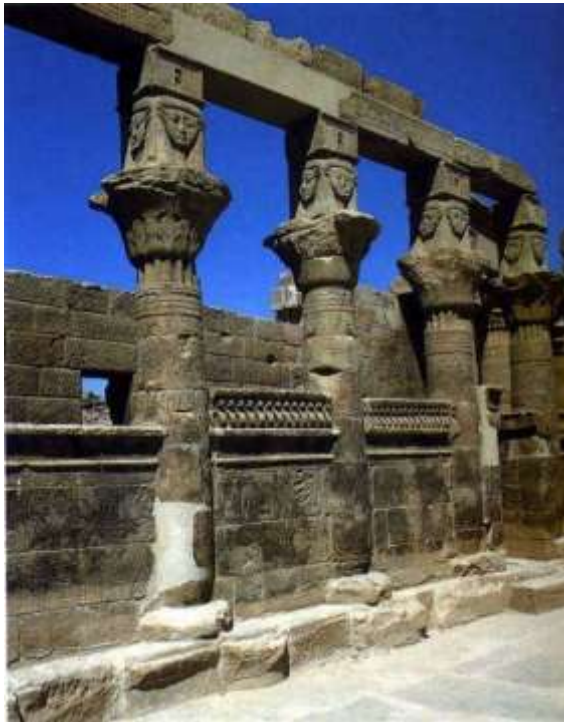
Gbr. 9.84. Dinding kuil Isis yang hampir mencapai kepala kolom
